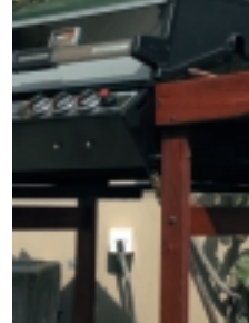
Hinter dem Gas-Grill die Erdgas-Steckdose – einstecken, ...
