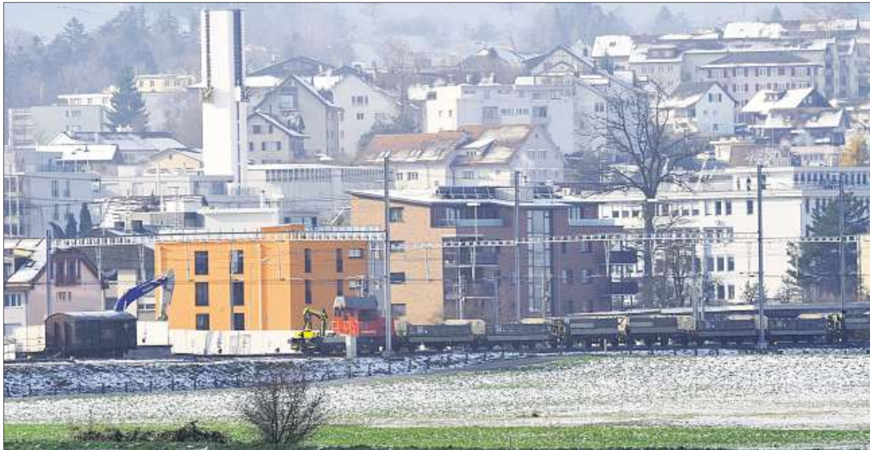
Die Bodenuntersuchung für die Umfahrung Pfäffikon ist abgeschlossen. Die Strasse wird bergwärts parallel zur Bahnlinie geführt. (Manuela Merk)
