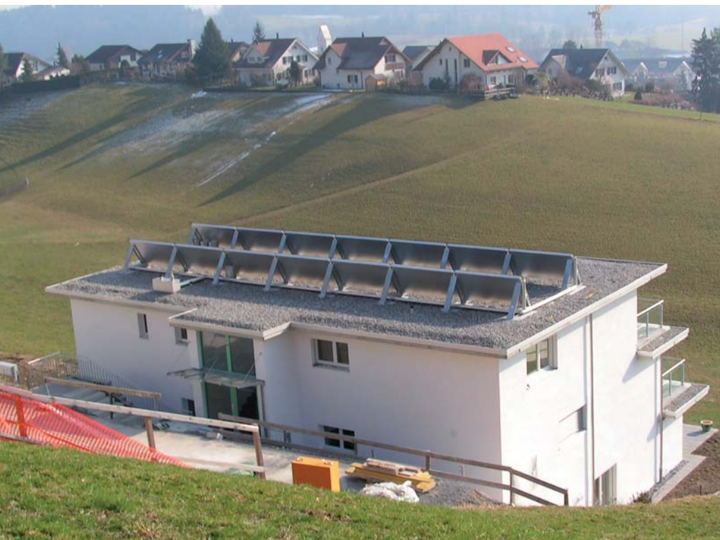
Die Sonnenkollektoren auf dem Dach geben ihre Wärme in ein Speichergerät ab und dienen in erster Linie der Warmwasseraufbereitung.
