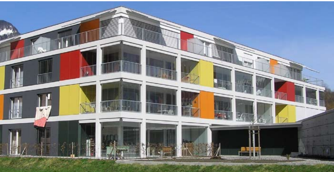
Der neue Wohnblock 4 mit 24 Alterswohnungen in Oberurnen verwendet als Energieträger Erdgas und Sonne.
