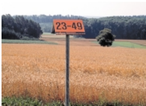
Nur kleine orange Schilder zeigen, wo Erdgasleitungen durchführen.
