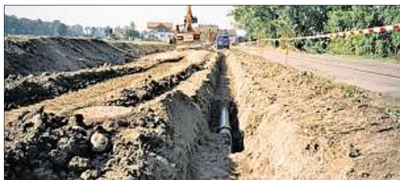
Demnächst beginnen die Bauarbeiten im Strassenbereich. (zvg)
