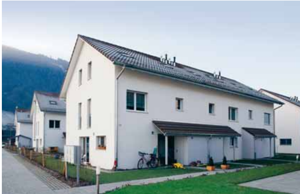
Die Häuser von der Rückseite mit überdachtem Eingang und Geräteschuppen. Neben den LAS-Stutzen münden auch Abluftleitungen
